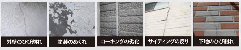
外壁のひび割れ 塗装のめくれ コーキングの劣化 サイディングの反り 下地のひび割れ
